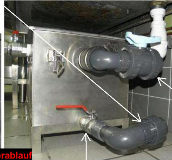
**Wasserablauf** aus dem Fettabscheider in den Abwasserkanal: der **Durchflussregler** ermöglicht eine einfache Demontage, um das Gerät vollständig zu reinigen.
