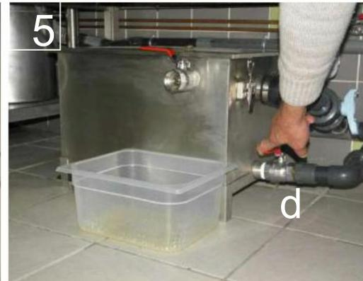
Öffnen Sie den Auslaufregler (d), um die feinen Rückstände am Boden des Abscheiders abzulassen, falls dieser angeschlossen ist. Ansonsten wird eine komplette Reinigung des Geräts alle 2-3 Monate erforderlich.
